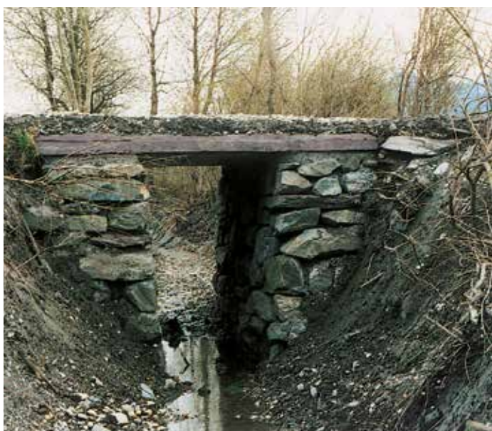
Eine der beiden im traditionellen Stil erbauten neuen Plattenbrücken.
