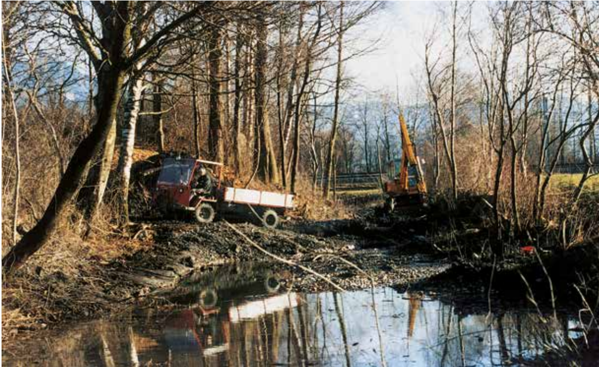
Aushubarbeiten im unteren Teil des Silbergiessens.
