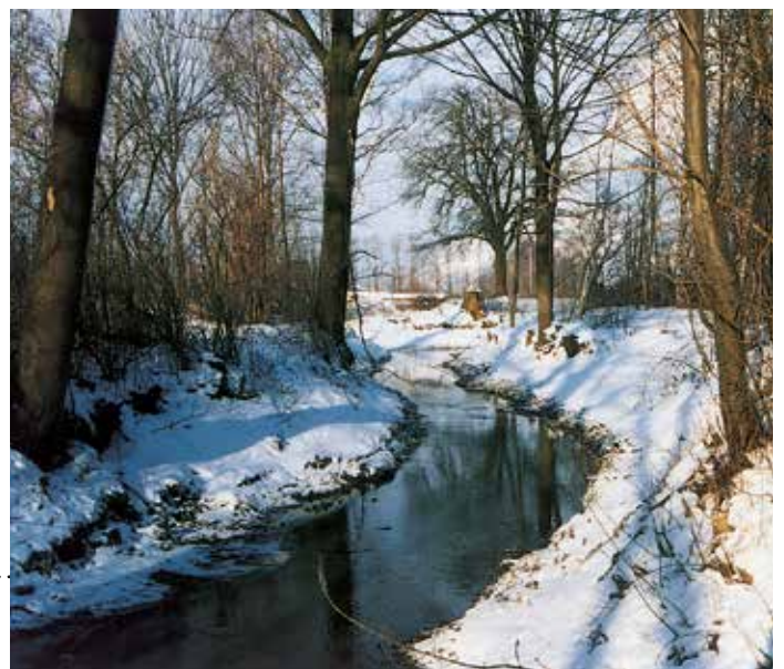
Ansicht des reaktivierten Silbergiessens im mittleren Bereich.
