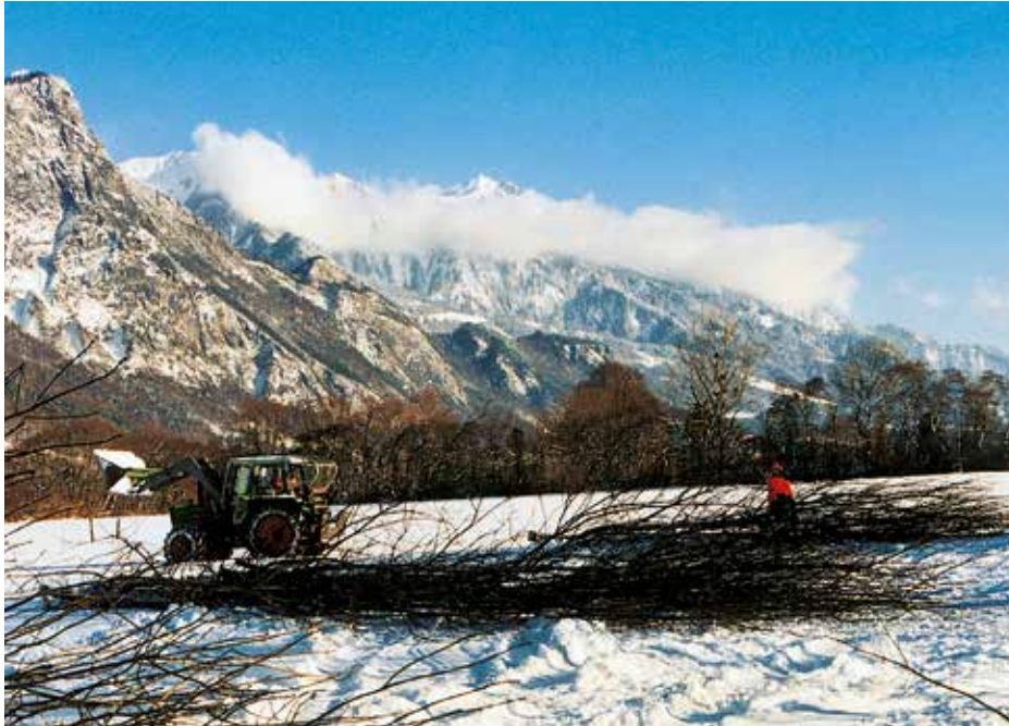
Rodungsarbeiten im oberen Teil des Silbergiessens.
